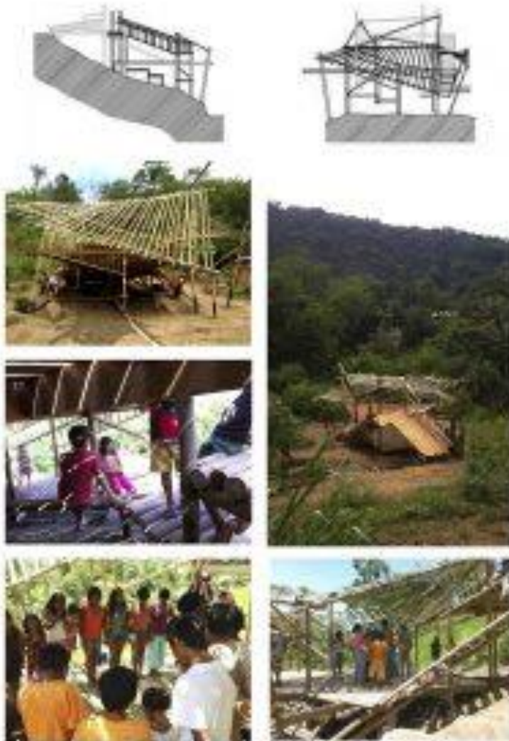
FIG. 5 La obra se conforma a partir de un suelo suspendido hacia las distintas orientaciones que constituyen el paisaje, conformando un refugio para realizar cantos y actividades propios de la comunidad Guaraní. Fotografía de autores.
