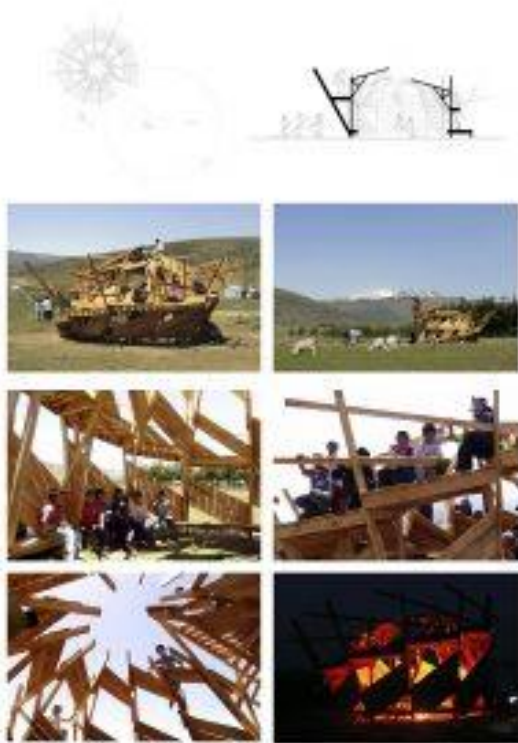
FIG.4 La planta arquitectónica del aula ruca de Marimenuco, se trabajó en un espacio circular concéntrico, con su acceso orientado al Pwel (oriente). La misma planta revela el vacío de la cubierta para evacuar el humo del fogón. Fotografía de autores.
