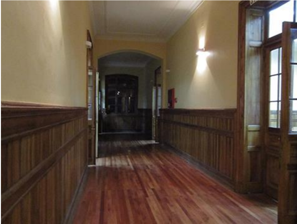
Fig. 5: La terminación del piso como así también los ventanales y puertas son elementos que se conservaron desde el punto de vista estético de la construcción, debido a que se reemplazaron las antiguas y desgastadas maderas por una solución moderna y de fácil mantención. Fuente: José Ignacio Díaz
