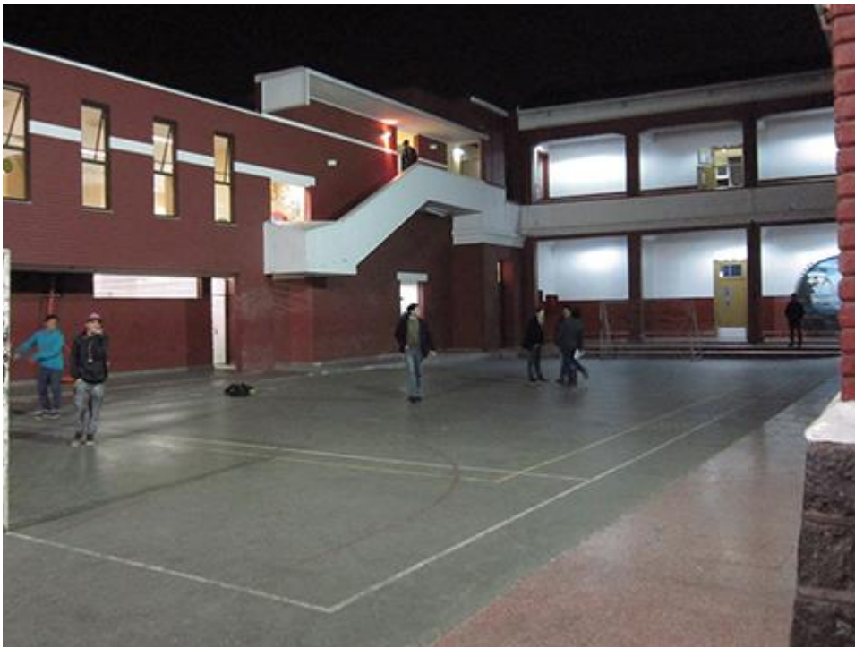
Fig. 3: El patio sur del liceo. La incorporación del edificio que alberga el programa de Biblioteca (izquierda de la fotografía) adiciona protección al acto deportivo que se realice. Fuente: José Ignacio Díaz
